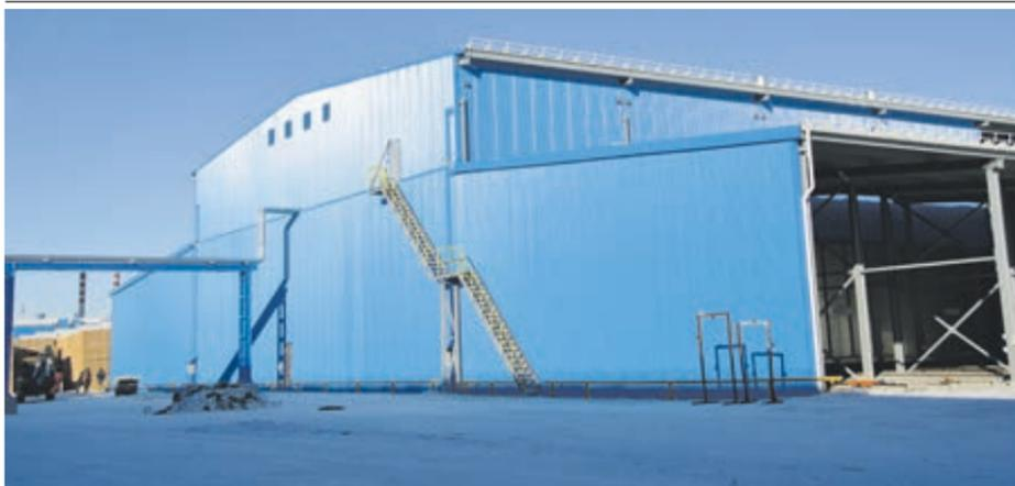
два блока двухэтапных сушильных туннелей фирмы Heipola производительностью 120 тыс. куб. м в год. Суммарная мощность всего сушильного комплекса достигнет 276 тыс. куб. м продукции в год, что полностью обеспечит потребности лесопильного производства предприятия по сушке выпускаемой продукции.
